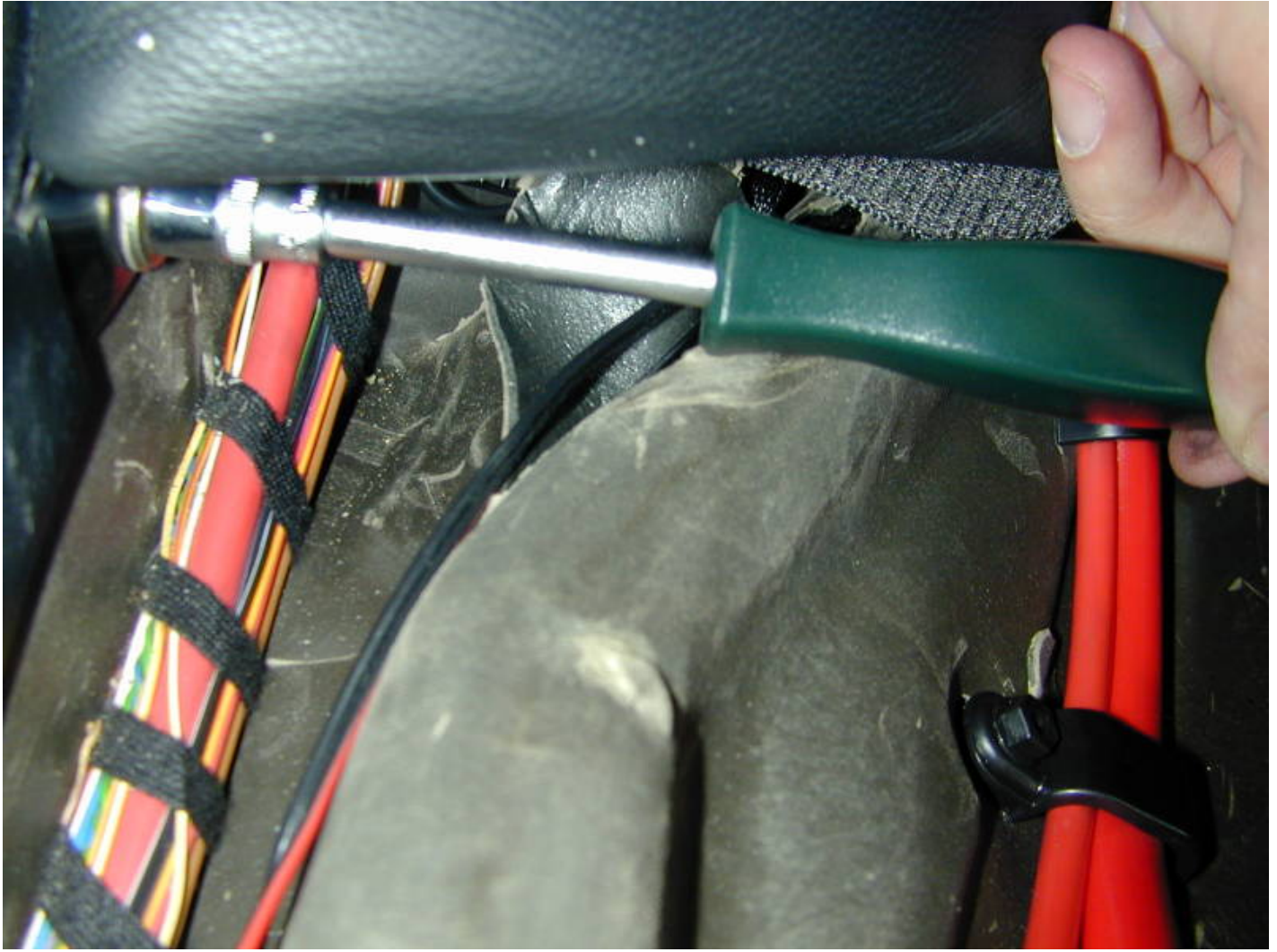
Aquí vemos el pasamuros con los cables de la batería:
